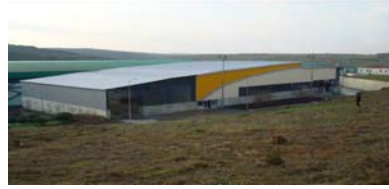
Şekil 1. RDF tesisi genel görünüm
