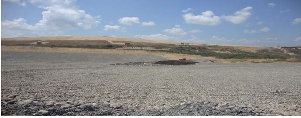
Şekil1. Birinci Sınıf (Tehlikeli Atık) Düzenli Depolama Sahası
