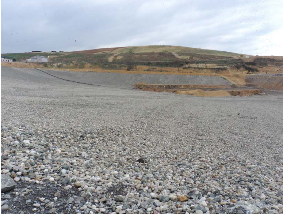
Şekil 7. 1nci Sınıf Düzenli Depolama Tesisi
